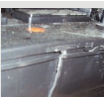
ROTA O DAÑADA Causado por un golpe, caída o mala sujeción.
